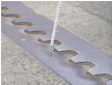
ゴムジョイントの損傷
