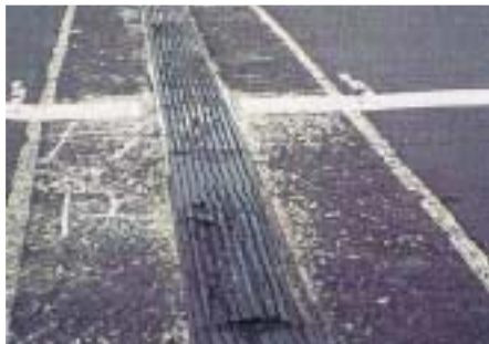
ゴムジョイントの損傷
